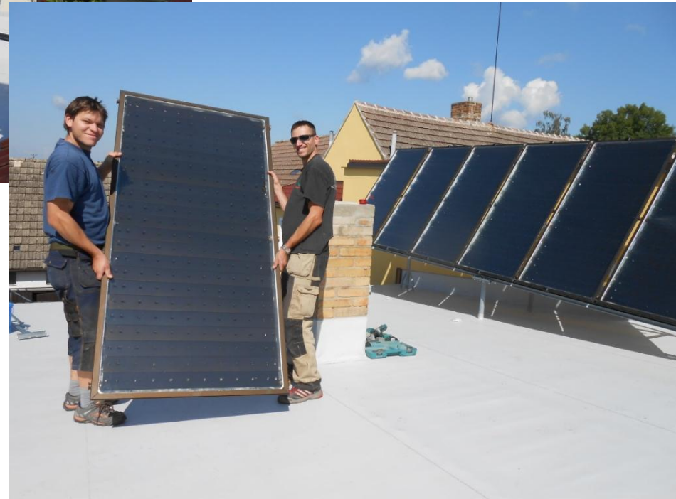
Montáž 7 ks vakuových kolektorů TS 400
