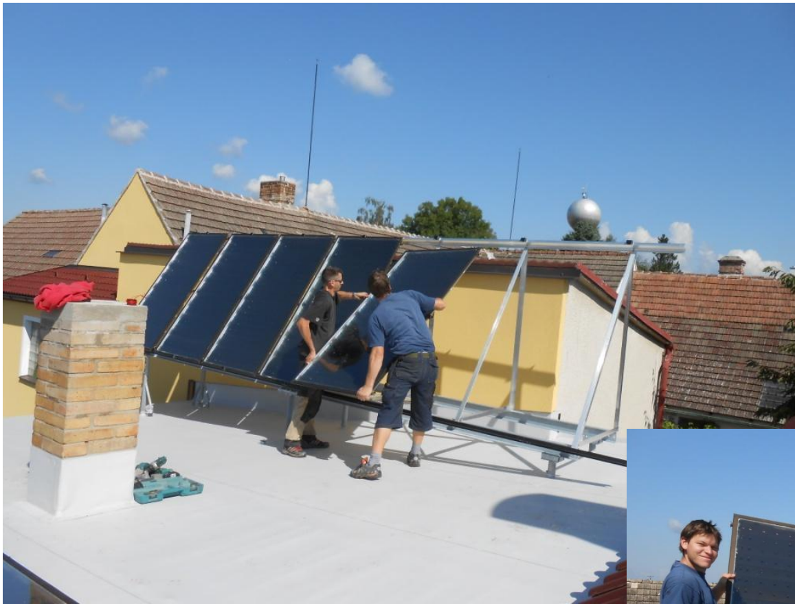
Montáž 7 ks vakuových kolektorů TS 400
